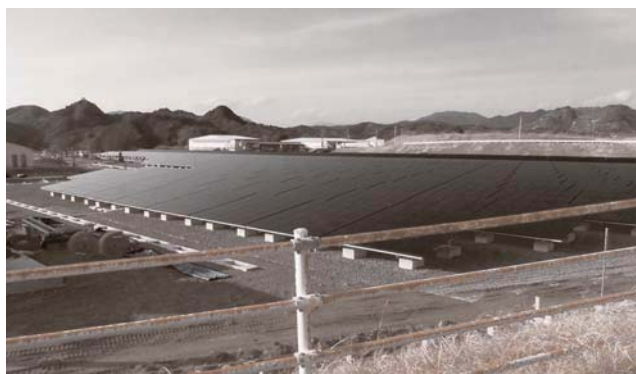
太陽光パネル
