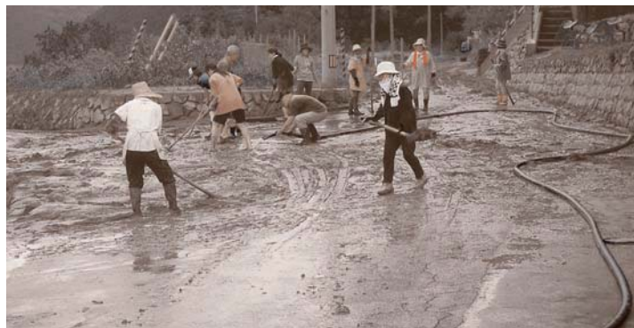
洪水後の地区民による道路の土砂取除き状況(勝間沈下橋右岸)
