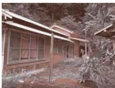
市内の空き家
