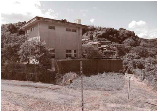
楠島排水機場
