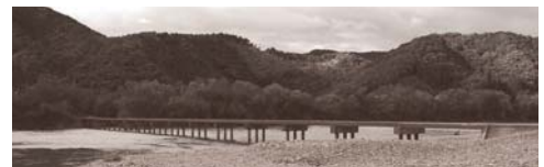
補強工事が急がれる勝間沈下橋
