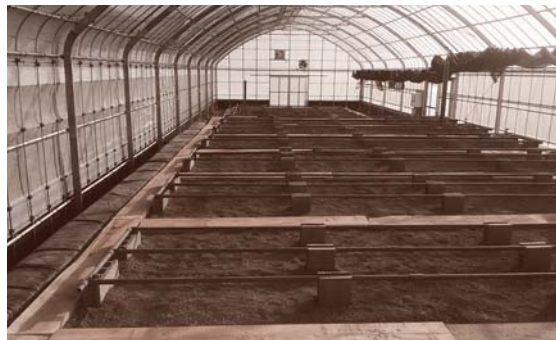
わさびの実証実験ハウスの施工中
