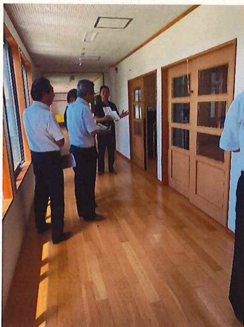
廊下の幅は2.4m。保育では荷物など置くものが多いので広くとっている。
