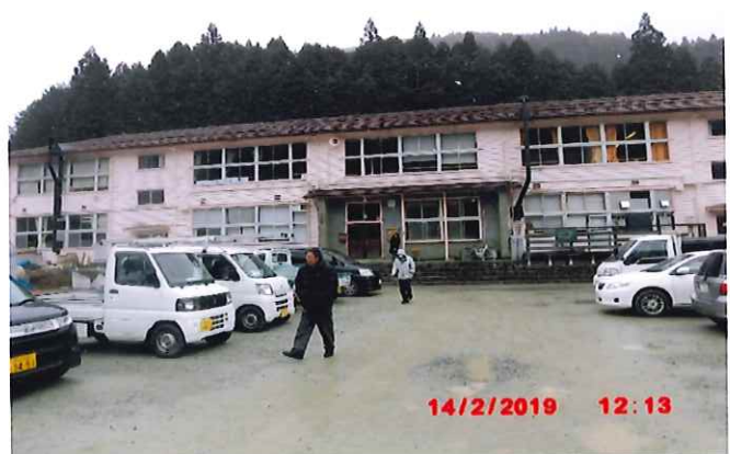
AO 株式会社等が利用する旧影石小学校舎
