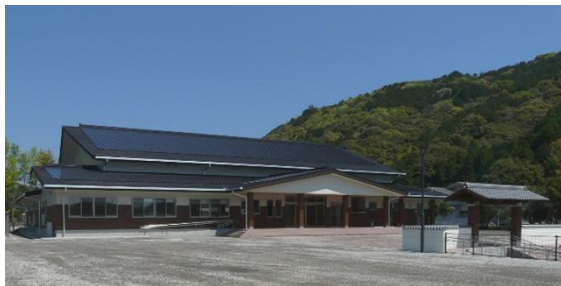
武道館(鉄骨造2階建:延べ床面積1,492㎡)
